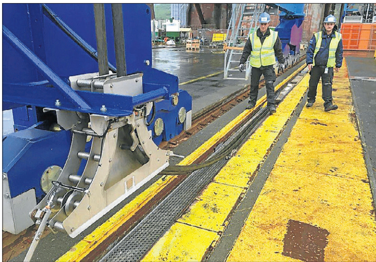
Håndteringen af powerkablet i havnekajen.
